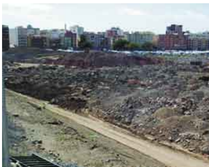
Estado actual de los antiguos terrenos Repsol, con la valla de Comarex a la entrada
