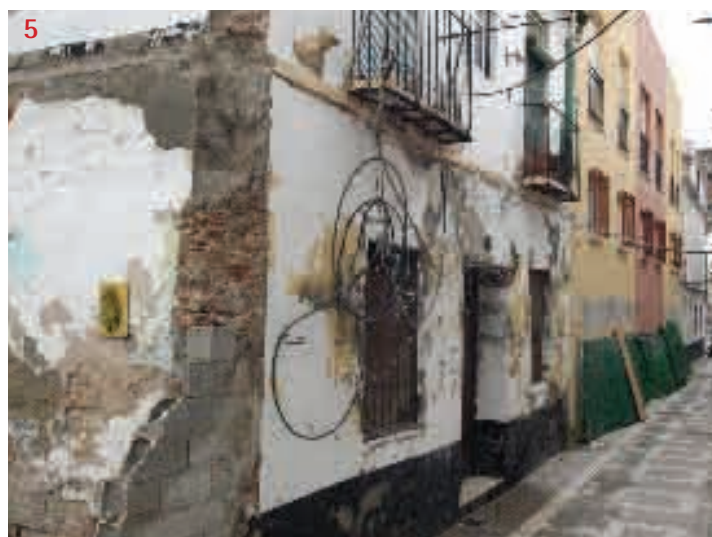
1 y 2: Edificio de calle Zurbarán 17 3 y 5: Edificio de calle Rosal Blanco 4: Calle Chinchilla
