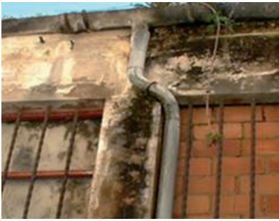
Canalón y bajante de recogida de aguas
