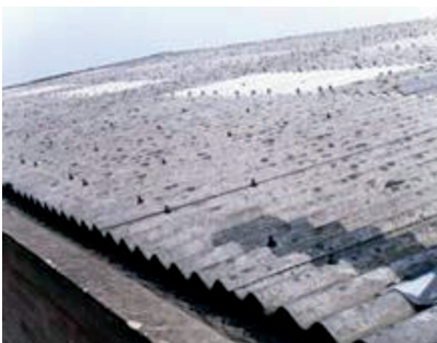
Planchas onduladas en techo
