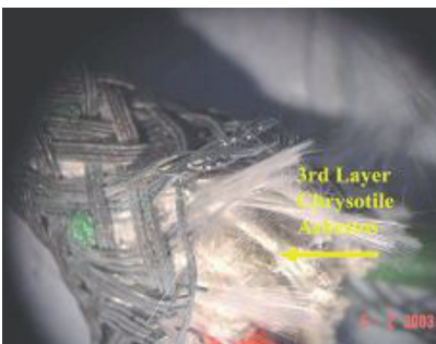
Aislamiento de cables
