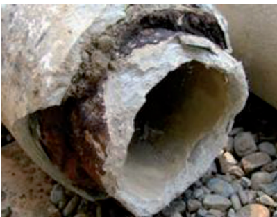
Tubería de fibrocemento
