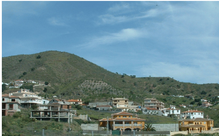
Fig.7. Viviendas en suelo rústico no urbanizable de Rincón (2004)
