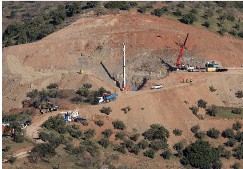
Fig.1. Panorámica de las obras para el rescate de Julen
